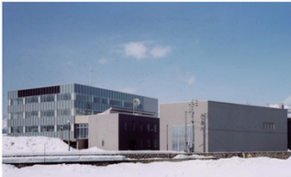
庁舎全体（左：本館 右：雪室）
